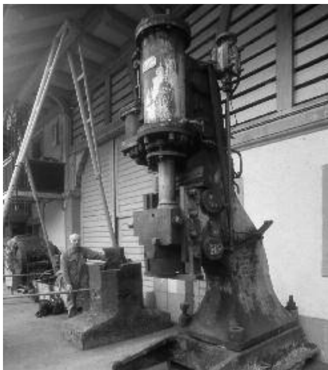
Dampf diente direkt und indirekt mannigfaltigen Antriebszwecken: Dampfhammer der SBB-Werkstätte Olten von 1904. Foto Hans-Peter Bärtschi 2000
