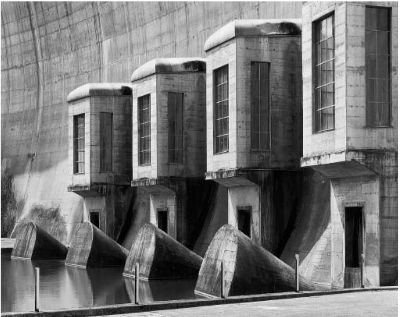
Staumauer, Kraftwerk Schiffenen, 1992
