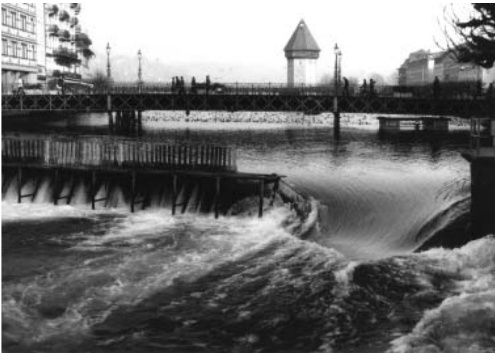
Lucerne, Seeabfluss mit Nadelwehröffnung bei mittlerem Wasserstand.
