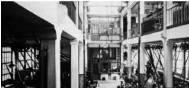
Usine de Dégrossissage d'Or (UGDO), après la reconstruction de 1916 Das Goldverarbeitungs-werk (UGDO), Neubau 1916
