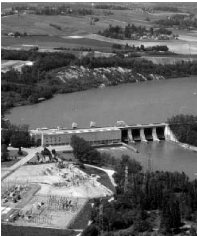
Centrale de Verbois Kraftwerk Verbois
