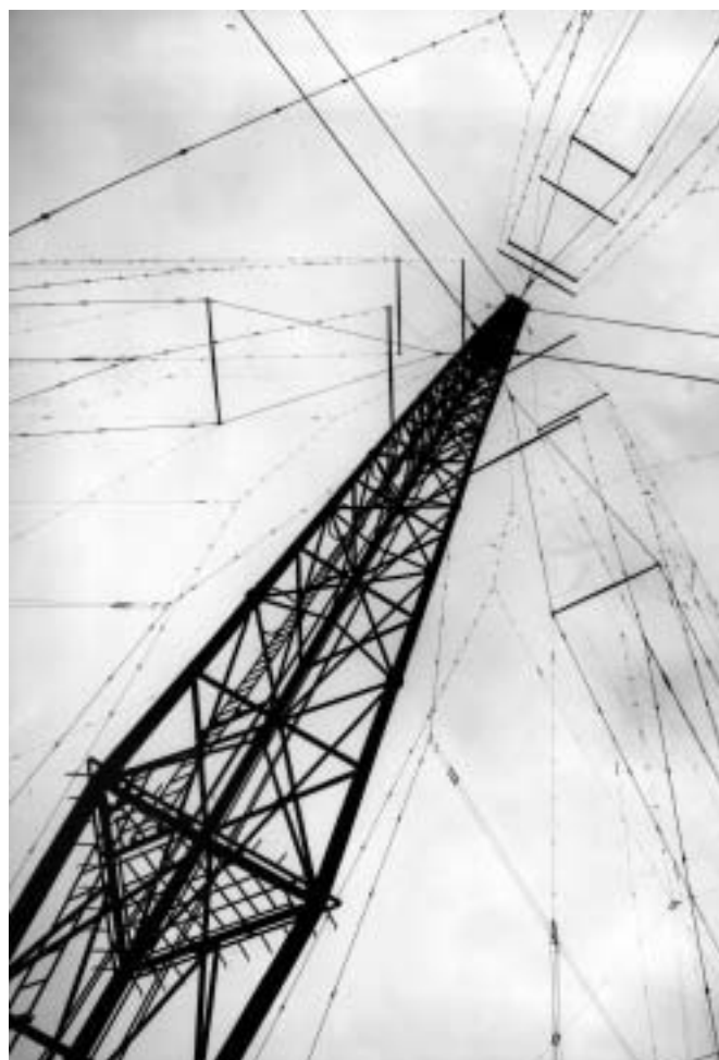
Vorhang-Antennenanlage in Schwarzenburg. Die sieben Masten und die zahlreichen dazwischengespannten Antennengruppen und Umschalter bildeten ein imposantes «Spinnennetz» in der Ebene bei Schwarzenburg.
