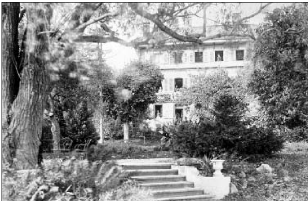
Foyer des Borel sur le littoral neuchâtelois: le Moulin de Bevaix.
