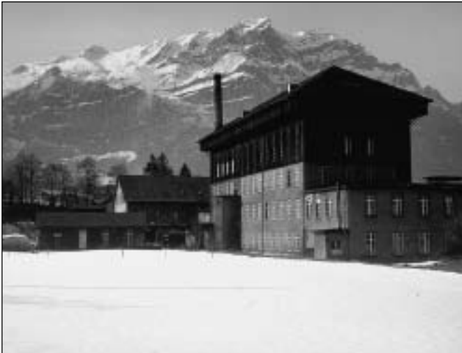
Tröckenturm der Stoffdruckerei, 1865, heute Museum für Ingenieurkunst Ennenda GL, Foto H.P. Bärtschi
