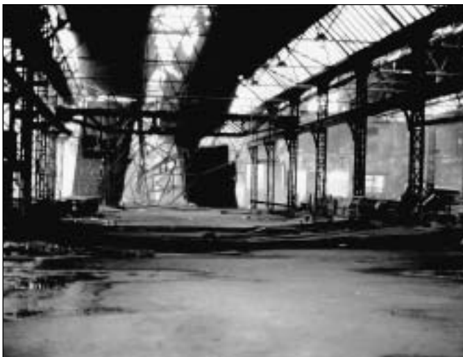
Abbruch Lastwagenfabrik Saurer Arbon TG, Juli 2001
