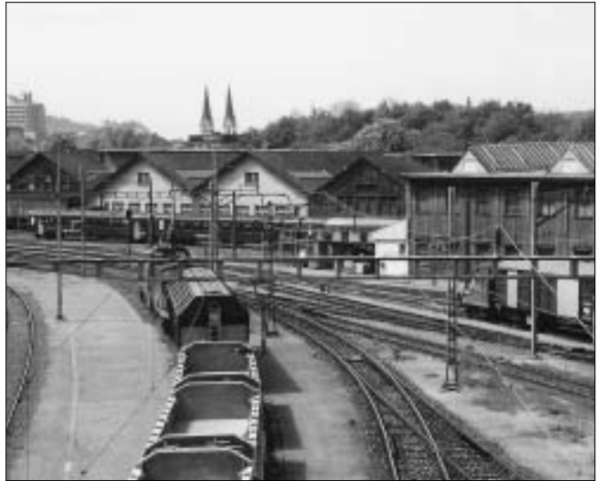
Die Werkstatthallen von 1853 bis 1943 sollen dem neuen Fernsteuerungszentrum weichen.
