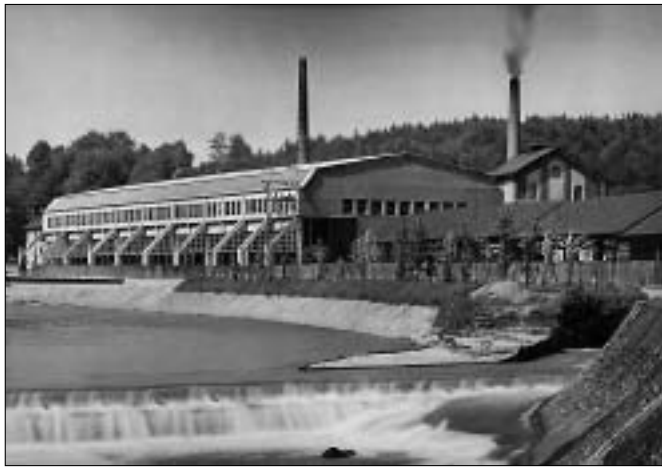
Stabeisenwerk mit Schrotthalle nach der Vollendung 1942
