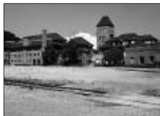
Sichtbacksteinfassaden der Viscose 1906 – 26
