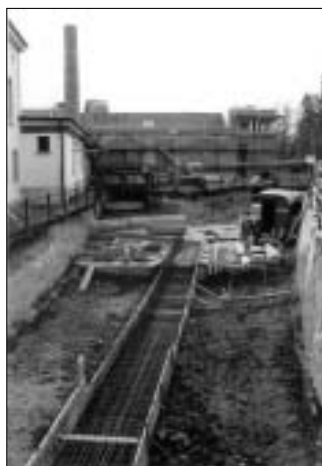
Bauarbeiten 2003 im Kanalbereich zwecks Erhaltung eines Teils der Wasserfläche. Foto H.P. Bärtschi
