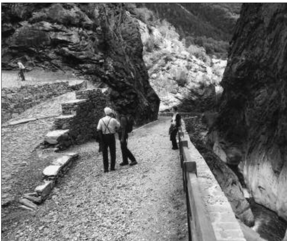
Die restaurierte Kurve der alten Kantonsstrasse weist originales Urner Kopfsteinpflaster auf.
