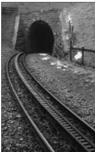
Riggenbach-Zahnstange auf der WAB, HB 1996
