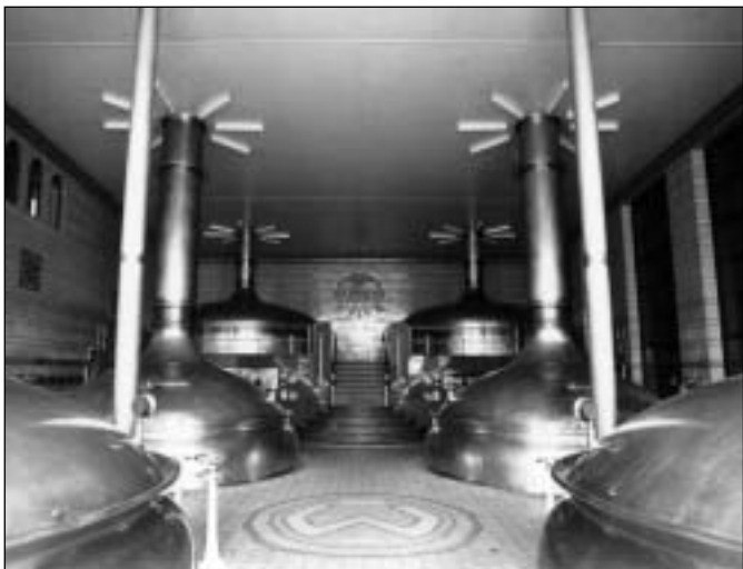
Sudhaus vor der Umnutzung, Foto 1990 Basler Denkmalpflege
