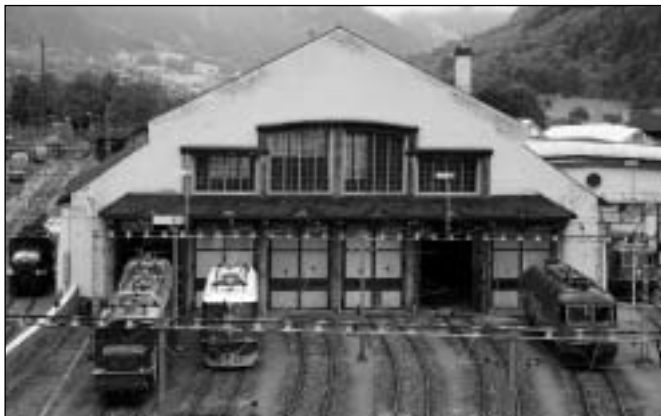
«Basilika» für Lokomotiven von Architekt Ramseyer in Erstfeld, Foto HPB. 2007
