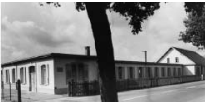
Das Gründergebäude der Nagelfabrik mit Satteldachanbau
