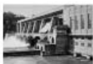
Die Tal-Front des Kraftwerks Eglisau vom linken Ufer aus gesehen im Jahre 1937 © ETH-Bibliothek Zürich, Dkt_247-10629, Leo Wehli
